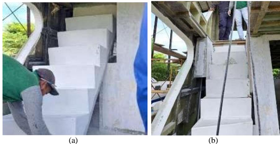
Gambar 5. (a) Pemasangan Tangga dan (b) Pelubangan Lantai *Fly Bridge Deck*
