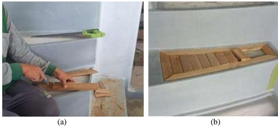
**Gambar 7.** (a) Pengukuran dan (b) Pemasangan Aksesoris Kayu
