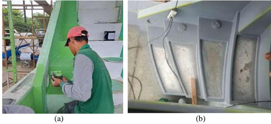
**Gambar 6.** (a) Pendempulan Tangga dan (b) Pengecatan Dasar Tangga
