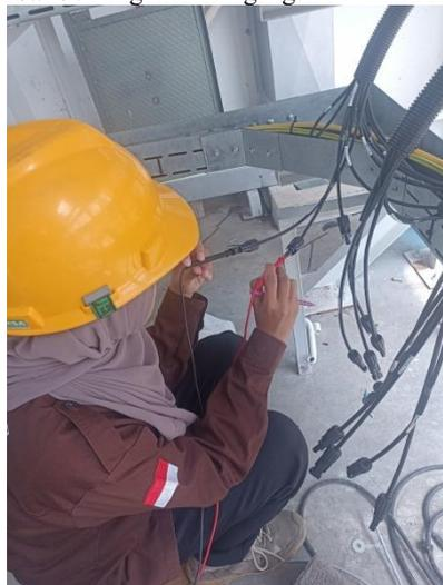
Gambar 10. Pengukuran tegangan Inverter
