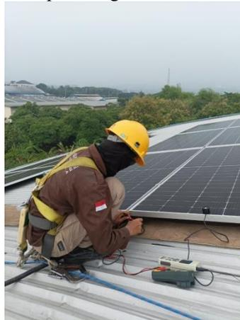
Gambar 9. Pengukuran tegangan PV dan I radiasi
