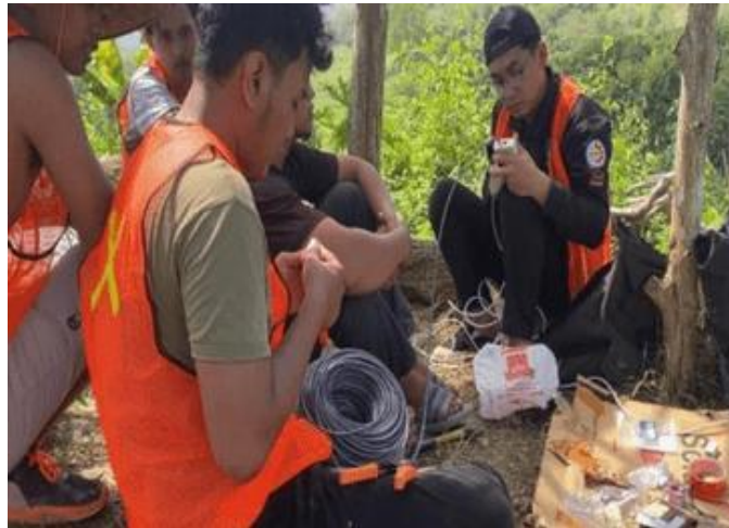
Gambar 5. Pemasangan Alat Pemancar Jaringan Internet
