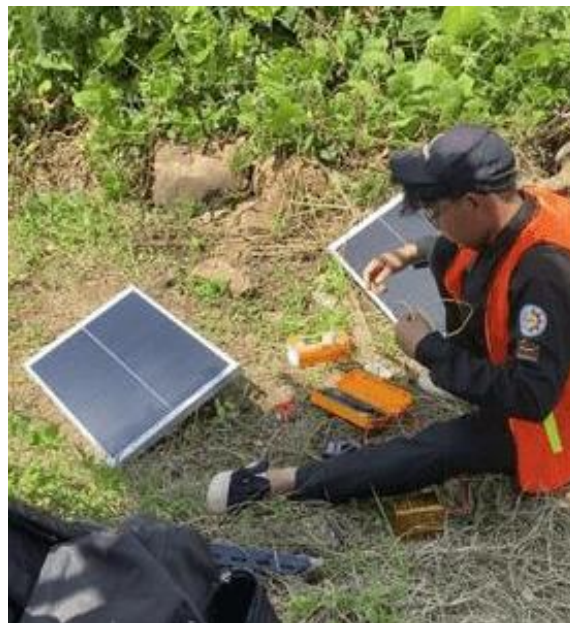
Gambar 6. Pemasangan Alat PLTS
